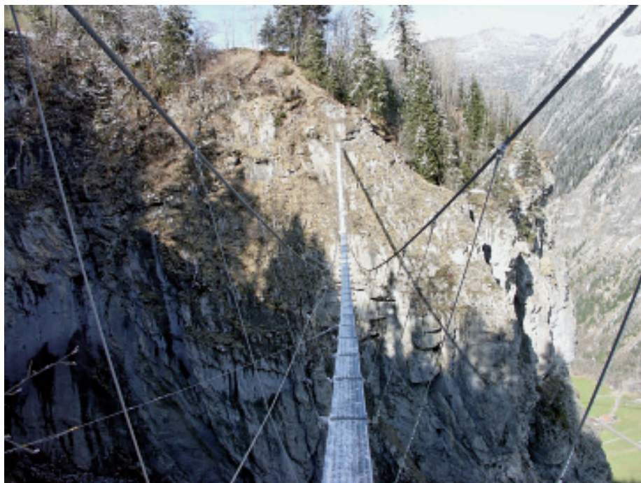
Hängebrücke Mürren Foto: MW Schweiz
